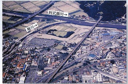
堀川改修状況
