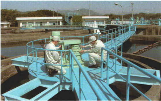
浄水施設の点検
