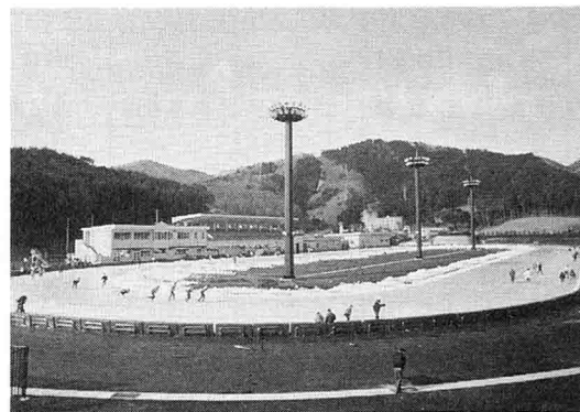
福島県郡山スケート場
