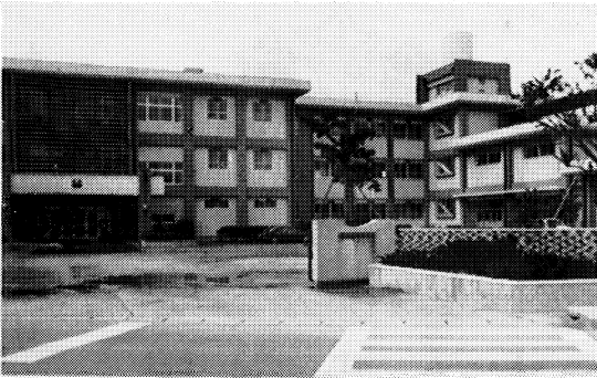
正門からみた南校舎（玄関側）
