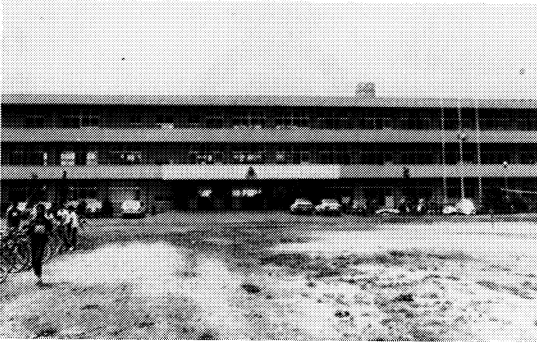
第1期改築校舎全景
