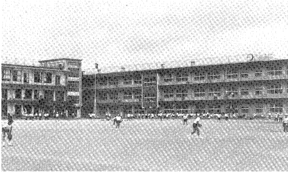
鉄筋三階の校舎
