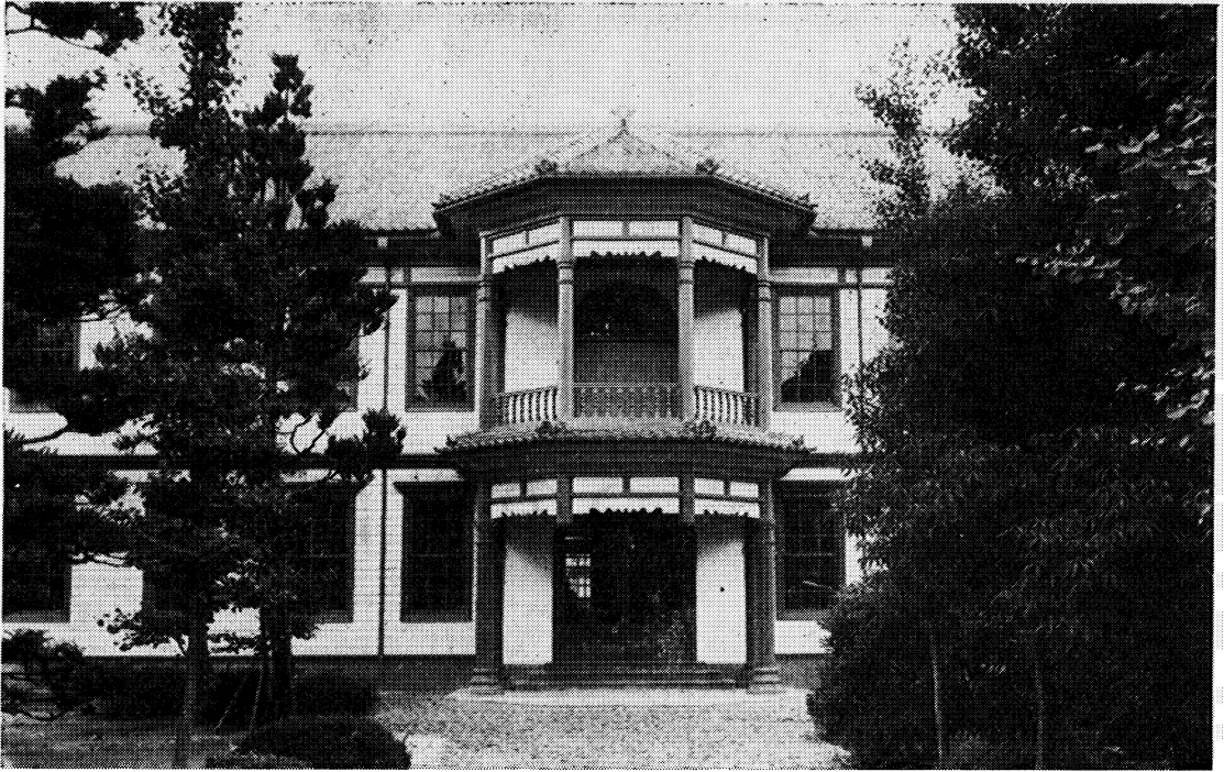
旧福島尋常中学校本館
