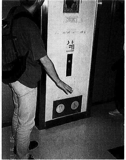
▲カリフォルニア大学パークレー校のエレベーター エレベーターの床に近いところに操作パネルがあります。押すというより蹴るという形で使います。もちろん車椅子の人でも楽に使えます。
