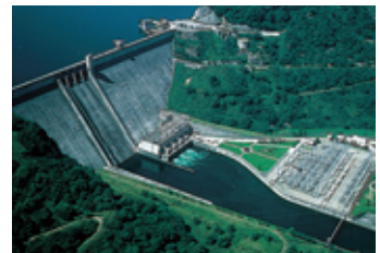
水力発電所（只見町）
