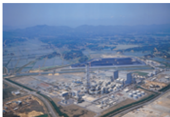
火力発電所（新地町）
