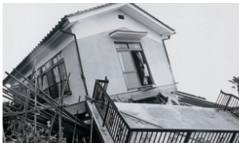
1978年（昭和53年）6月、宮城県沖地震により倒壊した民家（国見町）
