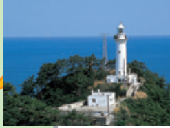
17 塩屋埼灯台 (いわき市)
