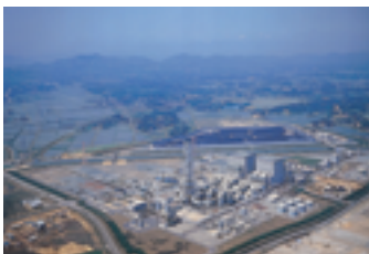
火力発電所 (新地町)
