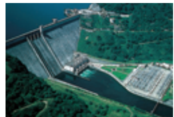
水力発電所 (只見町)
