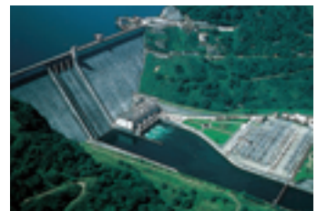
水力発電所 (只見町)
