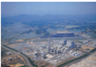
火力発電所 (新地町)
