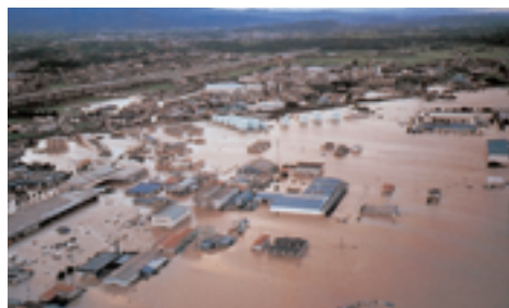
1986年（昭和61年）8月、台風10号による豪雨で、浸水による被害を受けた工場や民家（郡山市）
